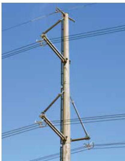
Фиг.5.5. Компактна линия от 420 kV близо до Кейптаун (двойно оформен дизайн).
