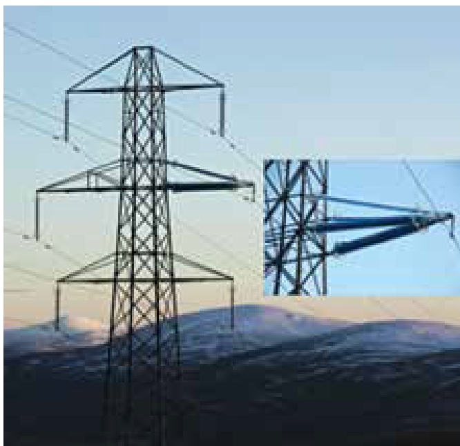
Фиг. 5.13: Изолиращо композитно напречно рамо на стълб 132 kV.
