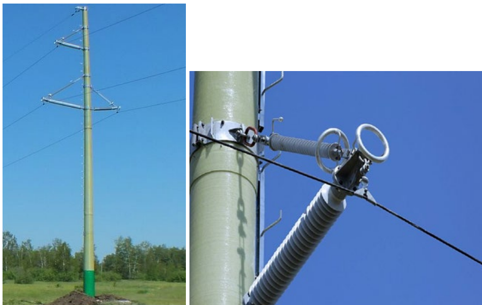
Фиг. 5.23: Композитен стълб 110 кВ с двойна линия с композитни конзоли, Феникс88
